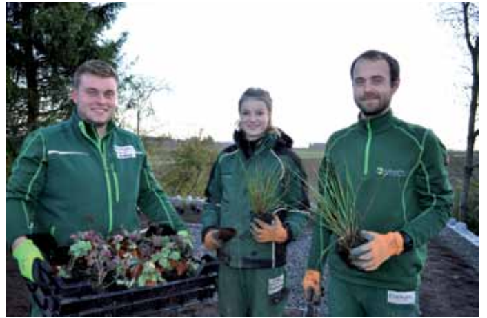
Im Team bepflanzten die Azubis der Firma Wildi das Dach des Hennenstalls, dem neuen Schulungs- und Kundenraum. Zudem dürfen sie den Natursteinbelag für Zugang und Terrasse erstellen. Chefin Claudia Wild ist begeistert vom Engagement der Belegschaft. (Foto: Fa. Wildi)
